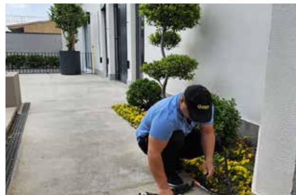
| پیاده سازی سیستم آبیاری قطره ای |
