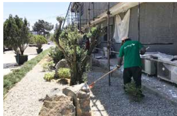
| اجرا شده در محوطه کارخانه کالین |
